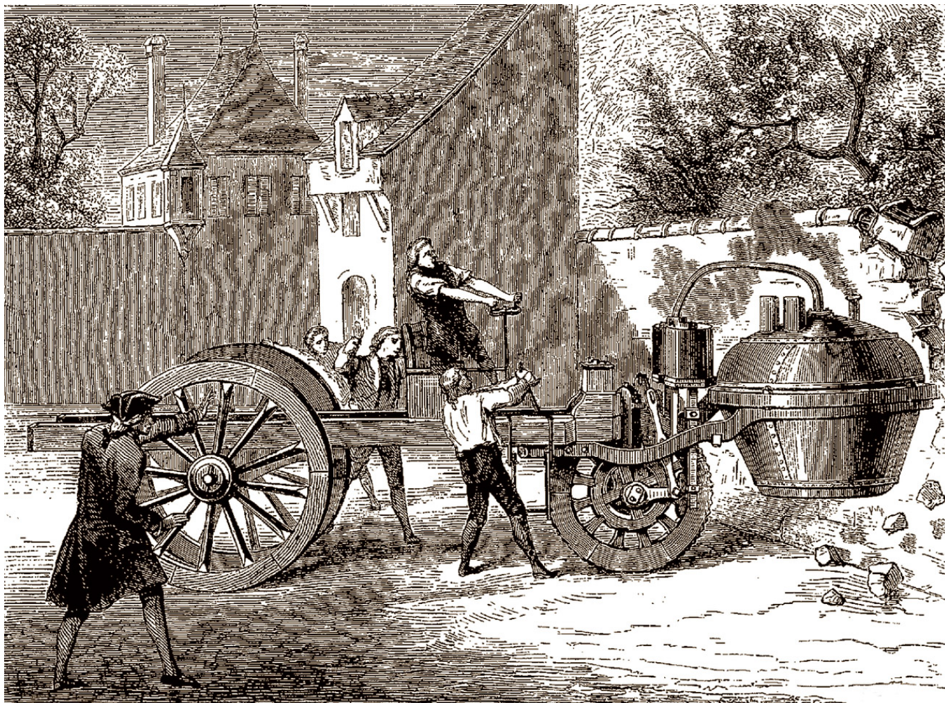
Nicolas Joseph Cugnot próbuje zatrzymać skonstruowany przez siebie pojazd napędzony maszyną parową podczas prezentacji w 1771 r.
